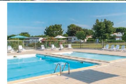
Piscine de la Résidence chauffée de juin à septembre
